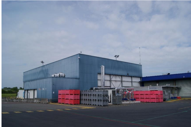
Photo 1 Usine Blédina avec les installations de la production de froid
